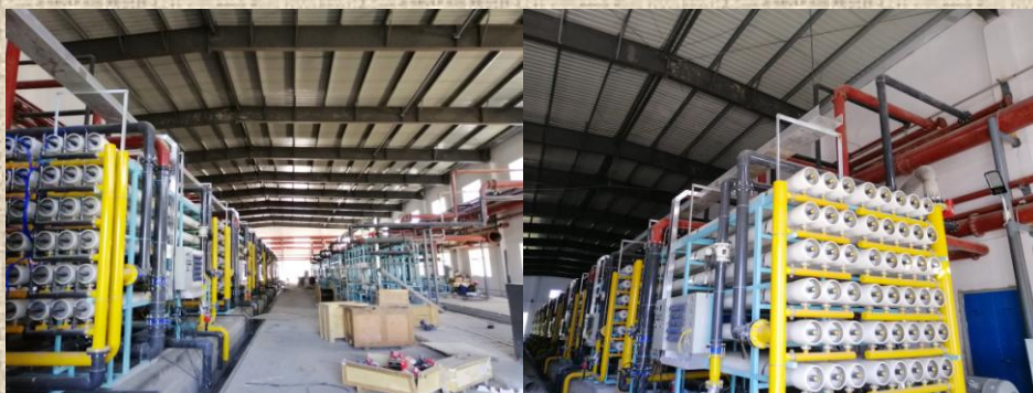
建设中的中水回用项目
