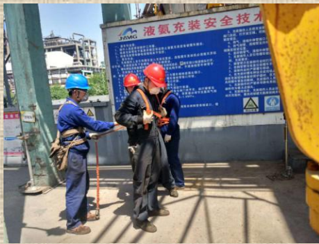
重大危险源检查
