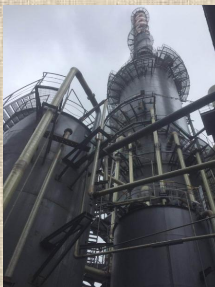
锅炉烟气超低排放改造项目
